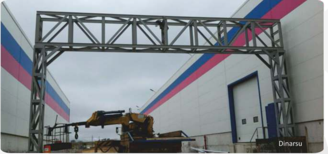
• Tesisat Geçiş Köprüsü
